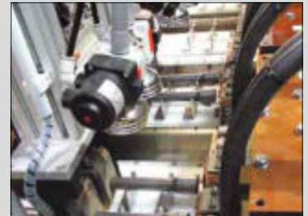
Prüfung von acht Bauteilen pro Takt (4 Mittenkontakte, 8 Joche)
