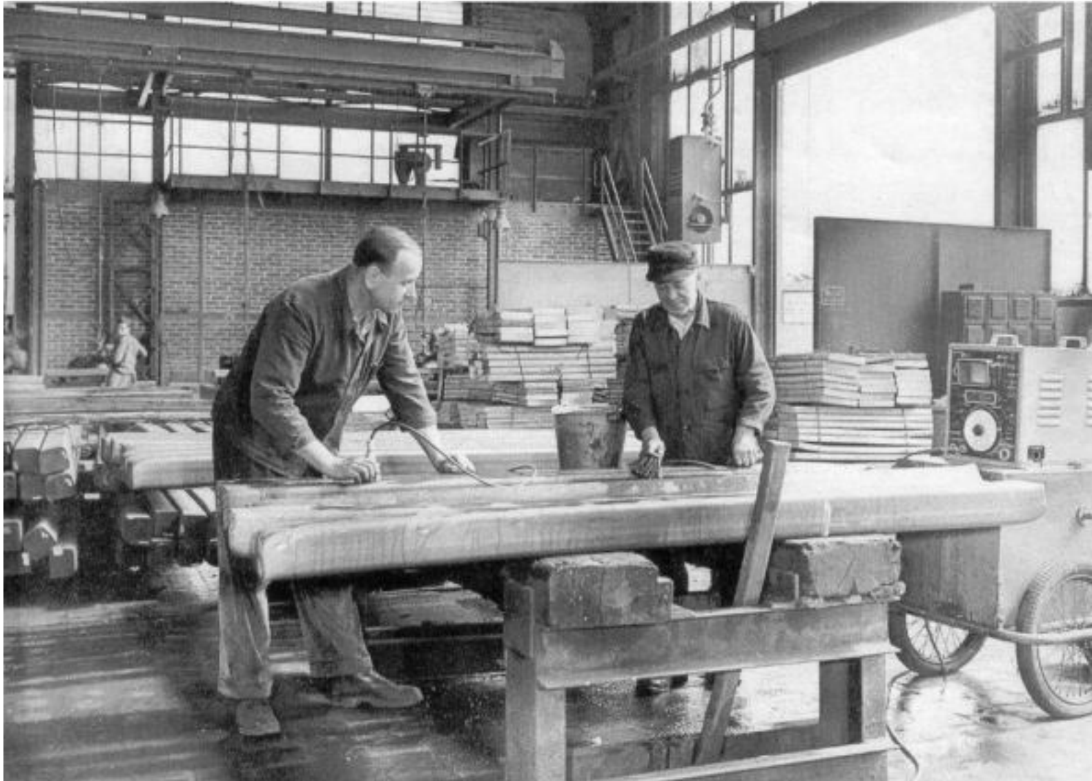
ECHOGRAPH UMG30: Knüppelprüfung @ Gussstahlwerk Witten (ca 1960)
