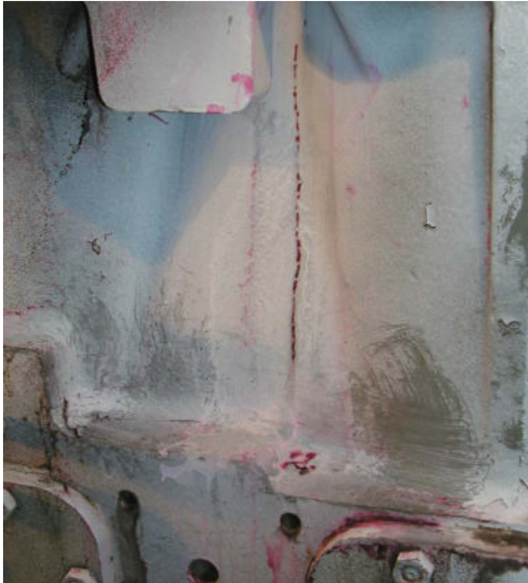
Eindringprüfung & Rissanzeige an Lokomotiv-Motorblock
