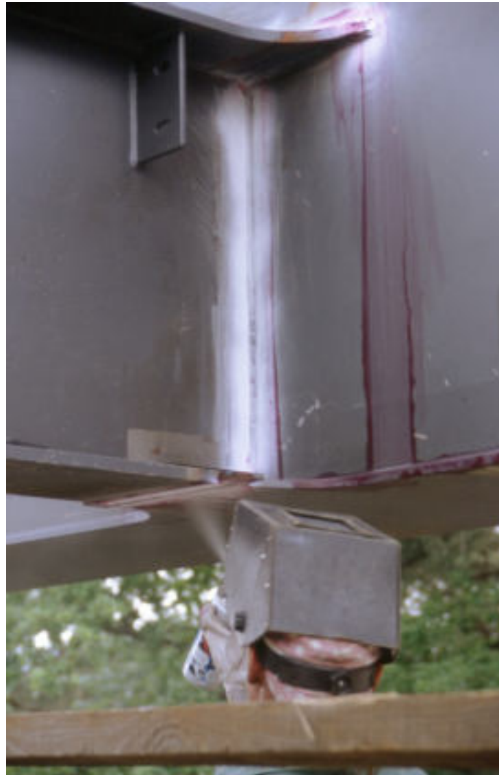
KD-Check: Schweißnahtprüfung (Eindringprüfung)
